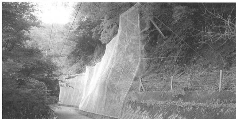
落石防止網が設置された町道立石線
