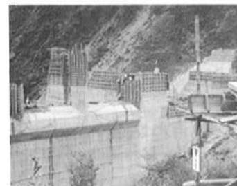
建設中の西山ダム
