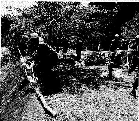
水防団による木流し工法
