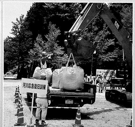
大型土のうを使った河川応急復旧訓練
