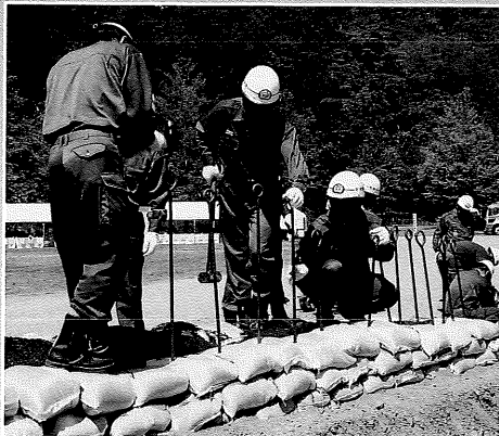
水防団による積み土のう工法
