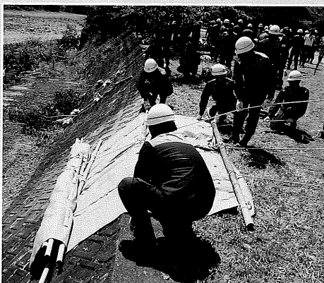
峡南建設事務所によるシート張り工法
