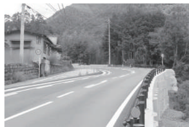
整備された保の県道
