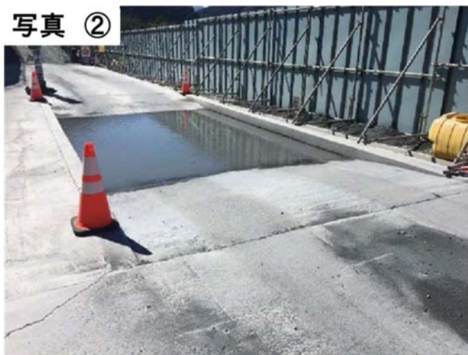
タイヤ洗浄設備の設置
