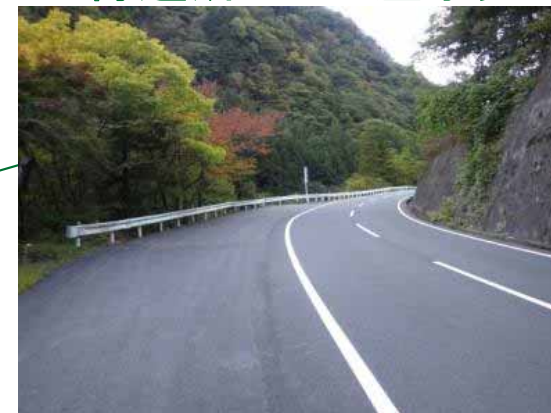
待避所: 下湯島手前
