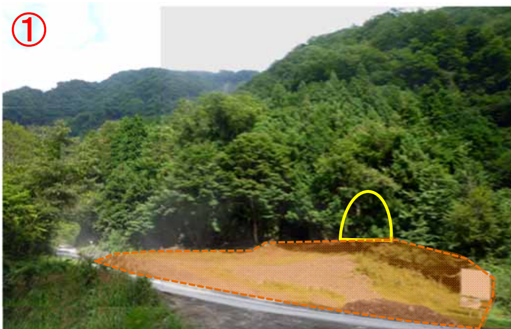
広河原非常口の全景
