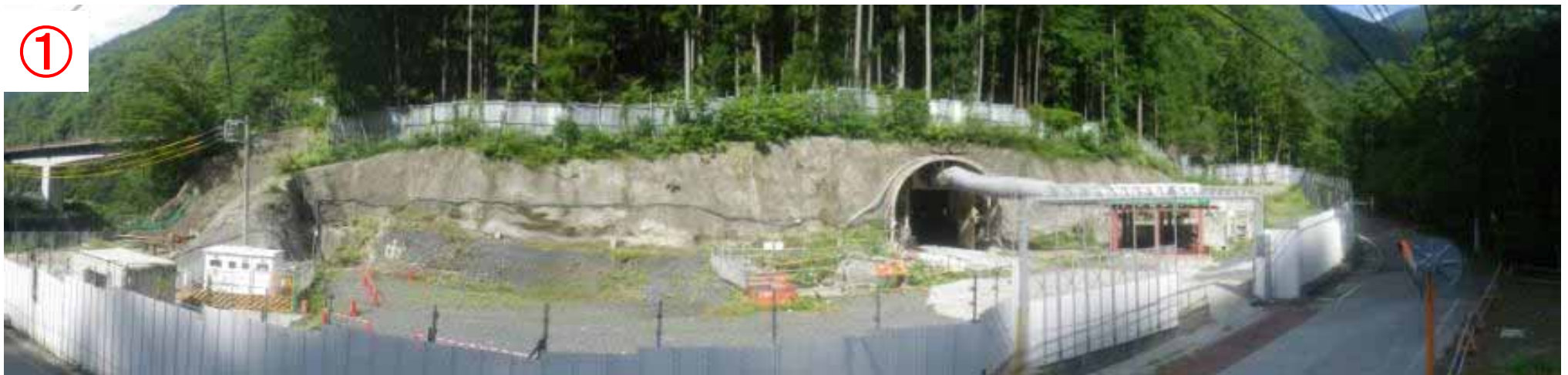
早川非常口の全景
