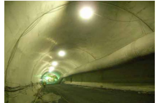
覆工コンクリート
