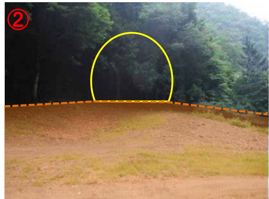
広河原非常口 正面
