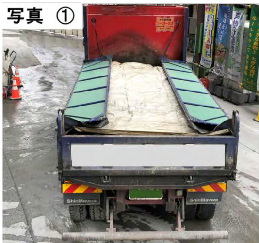
荷台への防じんシート等の設置
