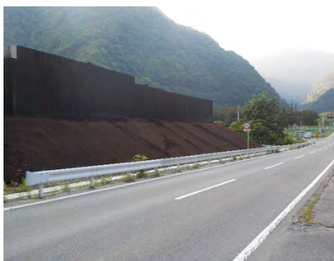
写真 4-1-3-5 仮囲い設置 (塩島地区発生土置き場)
