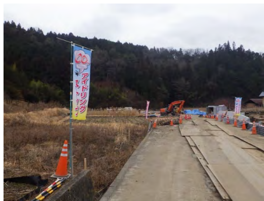
写真 4-1-5-2 建設機械の使用時における 配慮（アイドリングストップ の推進）
