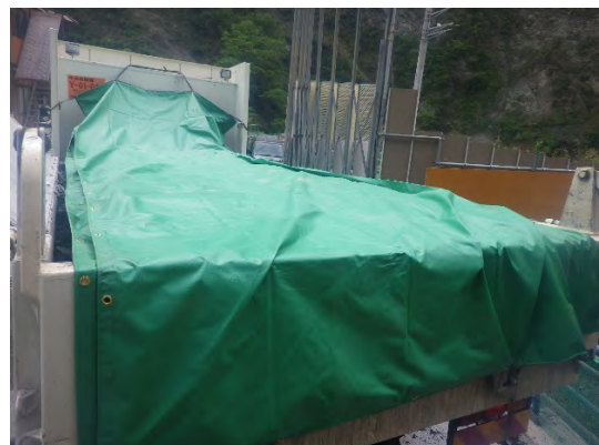
写真 4-1-2-12 運搬時の浸透防止シート設置 状況
