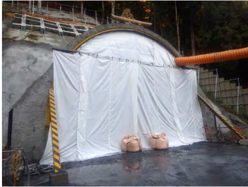
発破作業時の坑口状況
