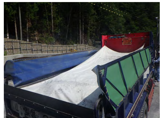
写真 4-1-4-6 運搬時の浸透防止シート設置状 況
