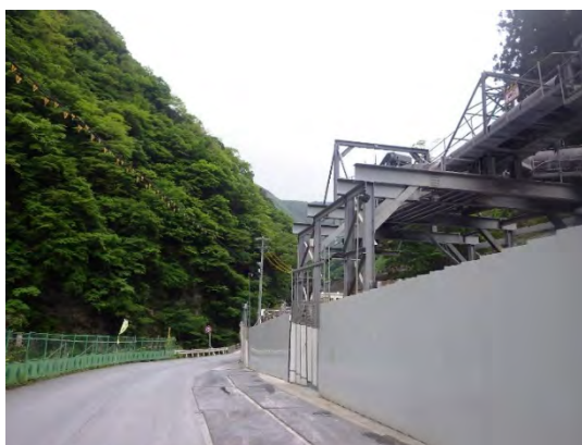
写真 4-1-2-5 仮囲いの設置 (早川非常口)
