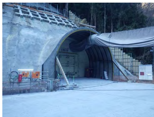
写真 4-1-2-16 防音扉の設置 （広河原非常口）
