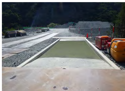
写真 4-1-3-4 タイヤ洗浄プール (塩島地区(河川側)発生土仮置き場)
