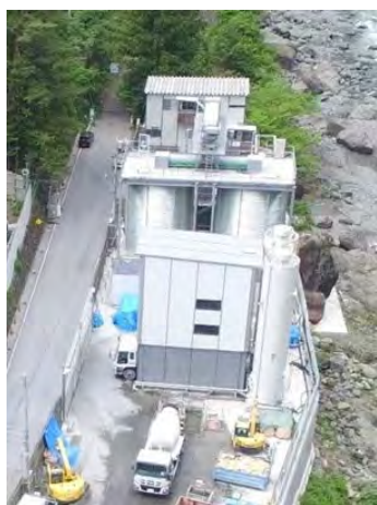
写真 4-1-2-21(1) バッチャープラント 建屋設置（早川非常口）
