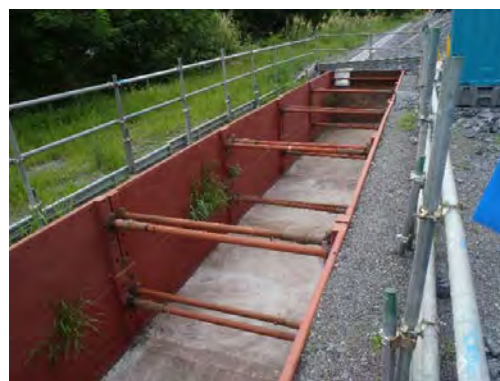
写真 4-1-3-6 沈砂池の設置 (塩島地区(河川側)発生土仮置き場)
