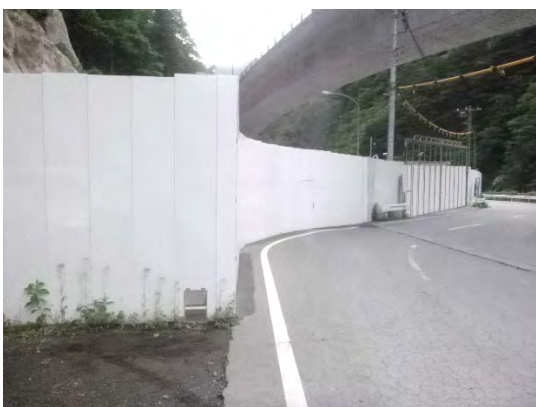
写真 4-1-1-12(2) 小動物が脱出可能な仮囲い
