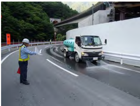
写真 4-1-1-7 道路への散水
