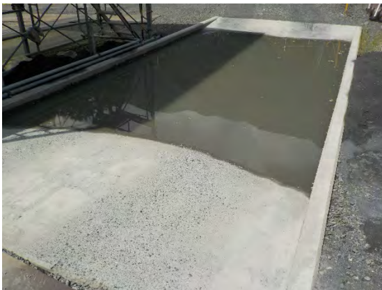
写真 4-1-4-5 タイヤ洗浄プール (塩島(下流)発生土仮置き場)
