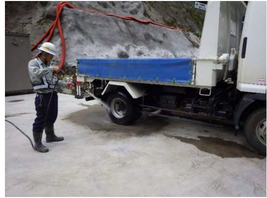
写真 4-1-2-8 外来種の拡大抑制 (タイヤ洗浄)
