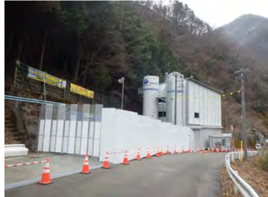
写真 4-1-1-6(2) 仮囲い、パッチャープラント 建屋設置
