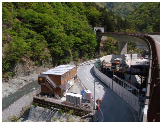
写真 4-1-1-5(2) 工事現場の清掃（清掃後）
