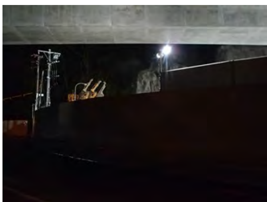
写真 4-1-1-13(2) LED 照明（点灯時）
