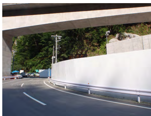
写真 4-1-1-13(1) LED 照明（点灯前）
