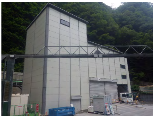
写真 4-1-2-21(2) バッチャープラント建屋設置 （広河原非常口）
