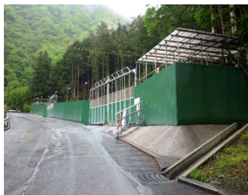
写真 4-1-2-14 侵入防止柵の設置 （広河原非常口）
