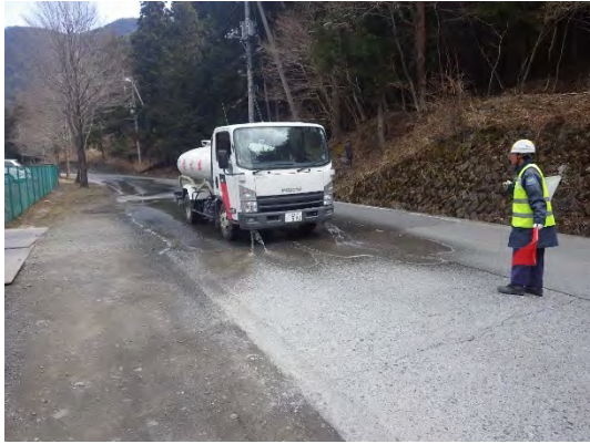
写真 4-1-2-7 道路への散水
