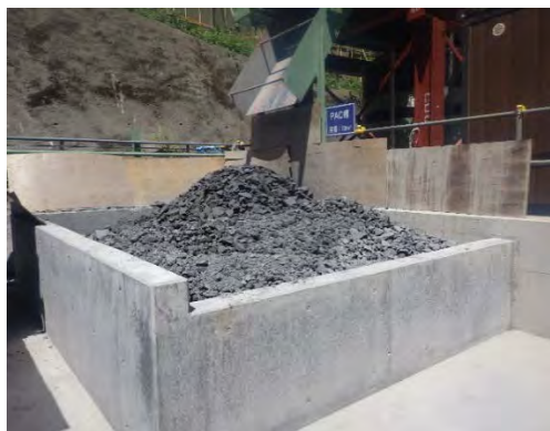
写真 4-1-2-19 建設汚泥の脱水処理 （早川非常口）
