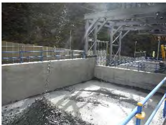
写真 4-1-2-13 土砂ピットにおける掘削土砂 管理（底盤及び周囲のコンク リート打設）（早川非常口）
