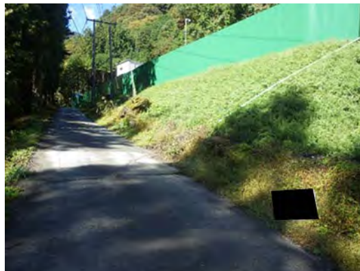
写真 4-1-2-18 のり面の緑化 （広河原非常口）
