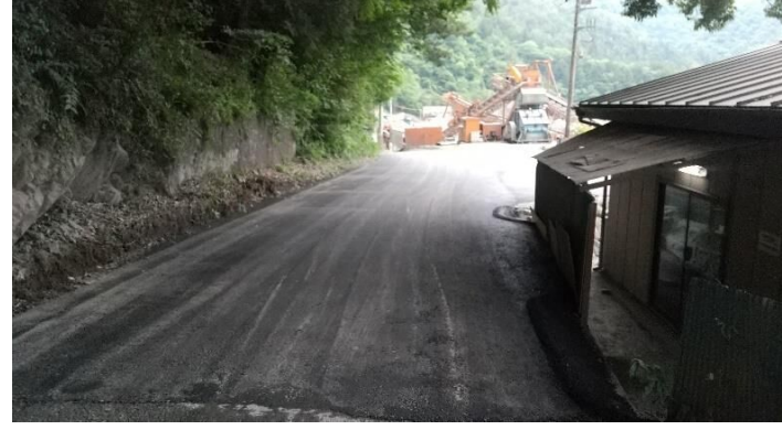
施工完了②
