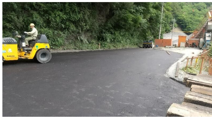
施工の様子④
