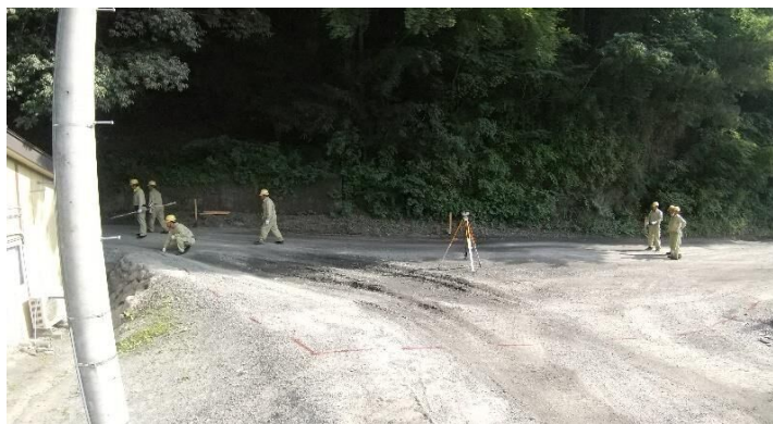
施工の様子①
