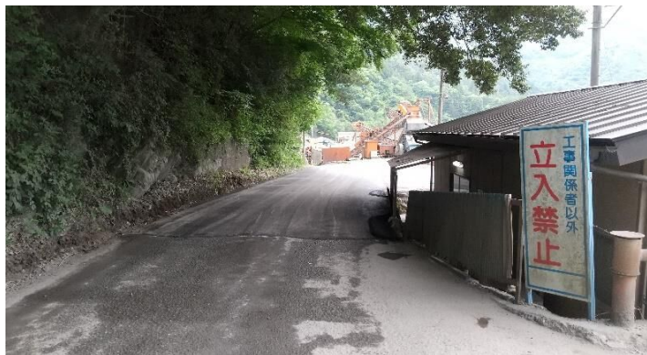
施工完了①
