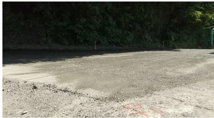
施工の様子②
