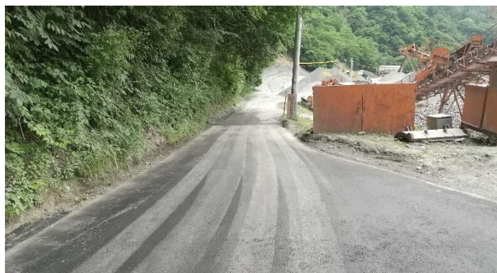
施工完了③
