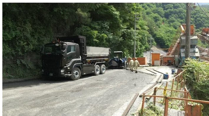
施工の様子③
