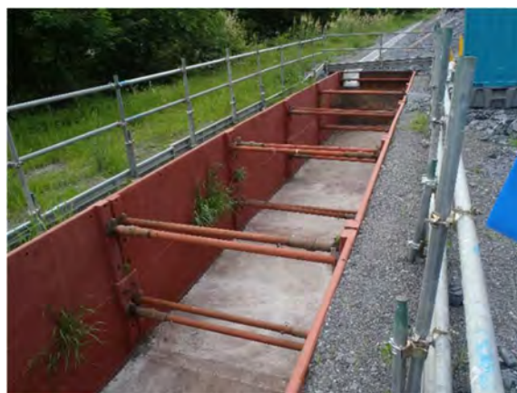
図 参 6-3-2 仮設沈砂池の設置 (塩島地区(河川側)発生土仮置き場)
