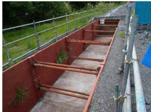
写真 4-1-9-6 沈砂池の設置状況
