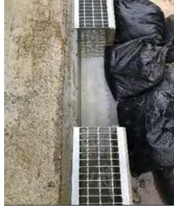
写真 4-1-6-14 小動物が脱出可能な側溝の設置
