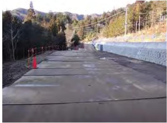
写真4-1-6-8 敷鉄板設置による粉じん抑制状況
