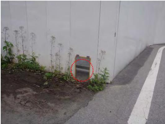
写真4-1-7-13(2) 小動物が脱出可能な側溝
