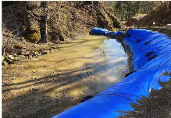
写真 4-1-6-15 仮設沈砂池の設置
