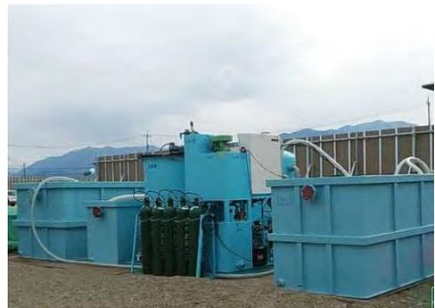
写真4-1-3-9 濁水処理設備の設置
