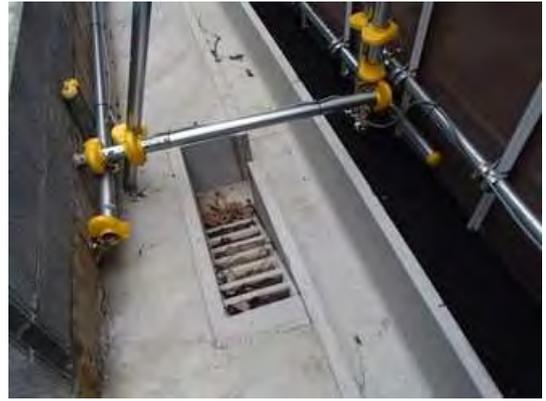
写真4-1-7-13(1) 小動物が脱出可能な側溝
