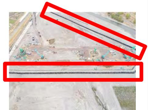
写真4-1-3-11 仮締切工の実施 (1)
