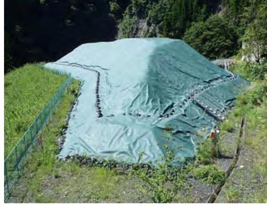
写真 4-1-10-8 遮水シートの設置状況
