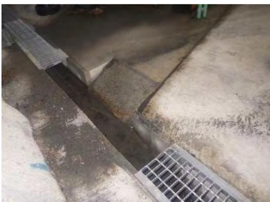
写真 4-1-8-16 小動物が脱出可能な側溝
