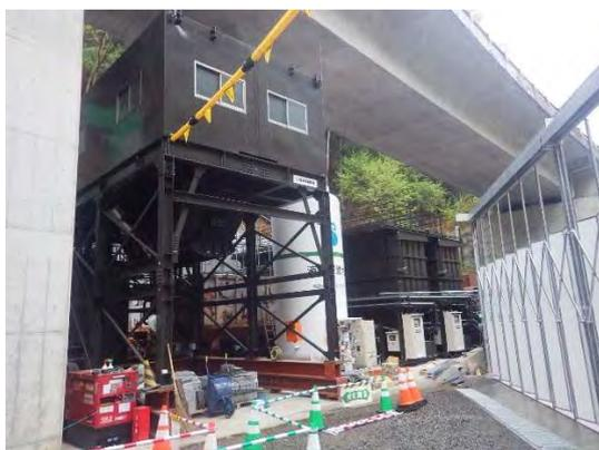
写真4-1-7-10 濁水処理設備の設置状況
