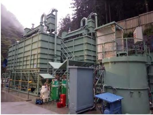
写真 4-1-8-12 濁水処理設備の設置状況
