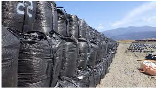
写真4-1-3-11 仮締切工の実施 (2)
