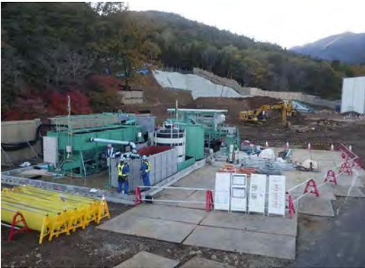
写真4-1-5-10 工事排水の適切な処理
