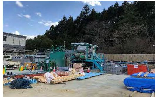
写真4-1-5-17 汚濁処理施設の設置
