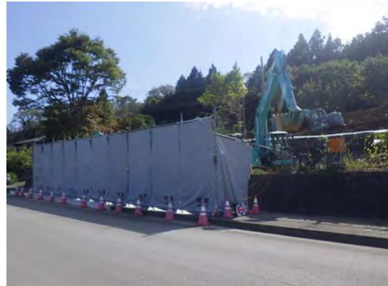
写真4-1-5-15 防音シート、低騒音機械の採用
