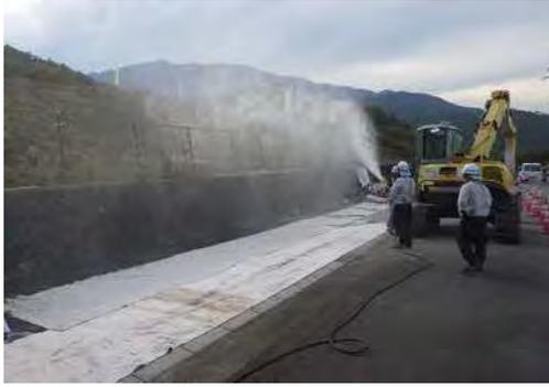
写真4-1-5-6 工事現場の清掃及び散水
