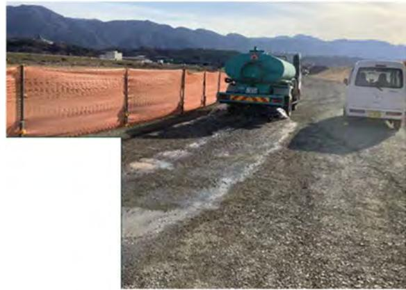
写真4-1-1-4 工事現場の清掃及び散水
