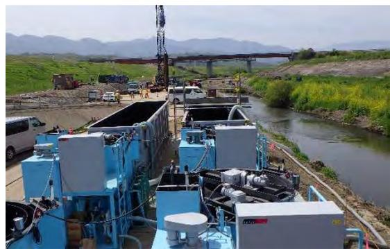
写真4-1-1-6 河川内排水時の適切な排水処理
