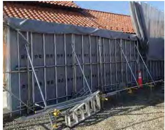
写真4-1-2-4 仮囲い・防音シート等の設置による遮音対策
