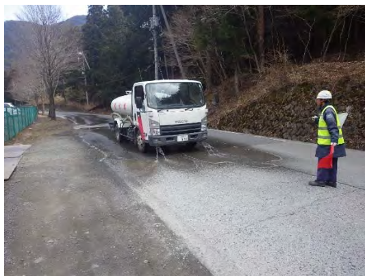
写真4-1-2-7 道路への散水
