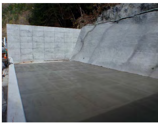
写真4-1-1-11(2) 土砂ピットにおける掘 削土砂の管理（底盤及び周 囲のコンクリート打設）
