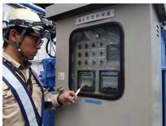
写真4-1-1-10 工事排水の監視 (濁水処理設備の監視・点検)
