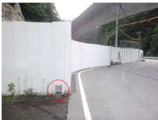
写真4-1-1-12(2) 小動物が脱出可能な 仮囲い
