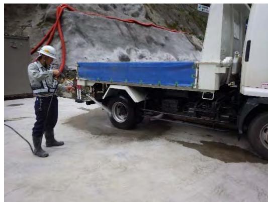
写真4-1-2-8 外来種の拡大抑制 (タイヤ洗浄)
