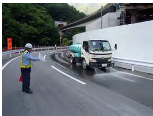
写真4-1-1-7 道路への散水
