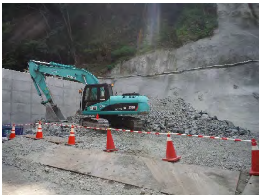
写真4-1-1-11(1) 土砂ピットにおける掘削 土砂の管理（底盤及び周囲 のコンクリート打設）
