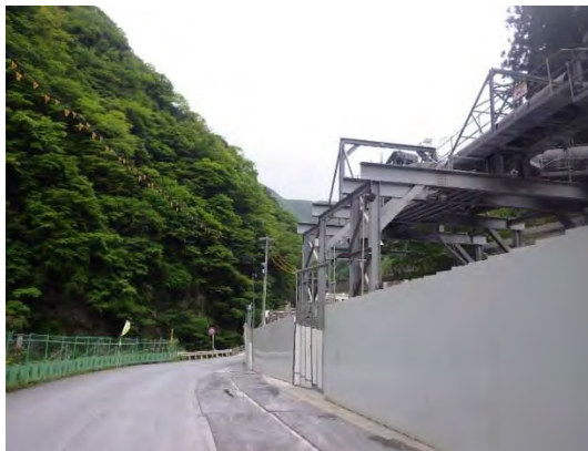
写真4-1-2-5 仮囲いの設置 (早川非常口)
