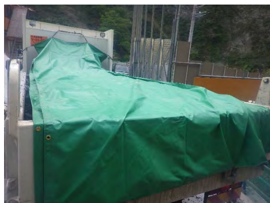
写真4-1-2-12 運搬時の浸透防止シート 設置状況
