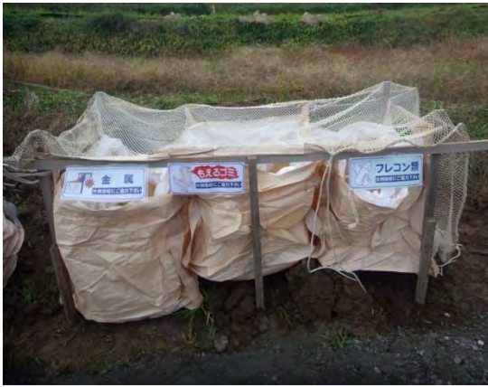
写真4-1-5-7 副産物の分別・再資源化
