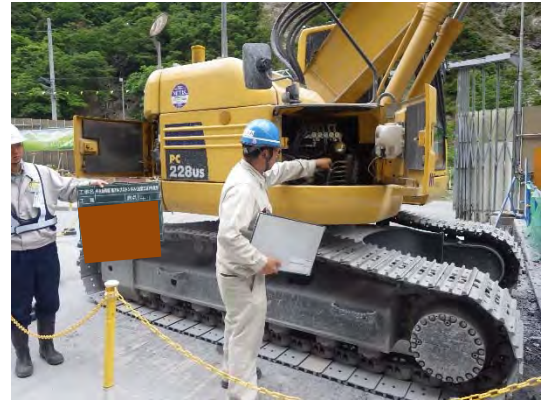
写真4-1-2-2 建設機械の点検・整備
