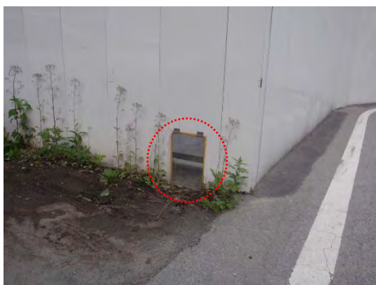
写真4-1-1-12(3) 小動物が脱出可能な 仮囲い
