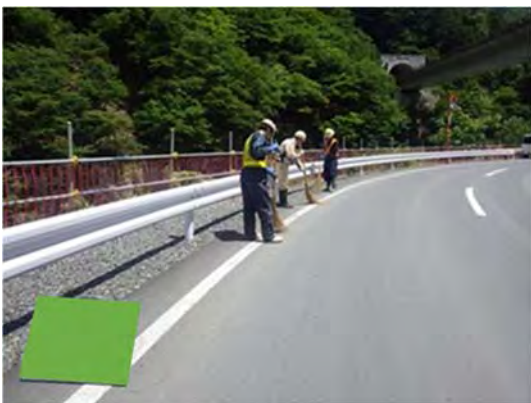
写真4-1-1-5 工事現場の清掃
