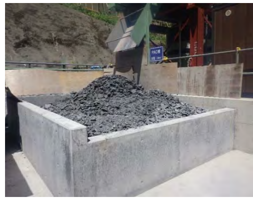
写真4-1-2-19 建設汚泥の脱水処理 (早川非常口)
