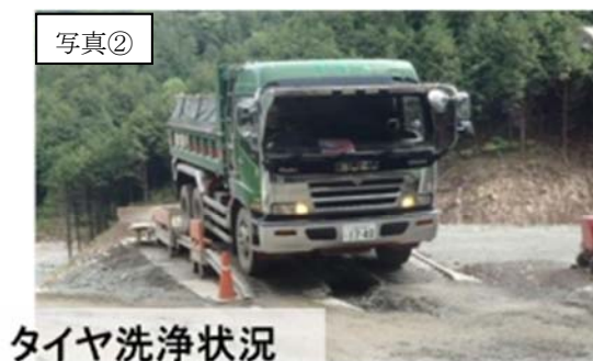
図 3-8 資材及び機械の運搬に用いる車両の運行による影響を低減するための環境保全措置
