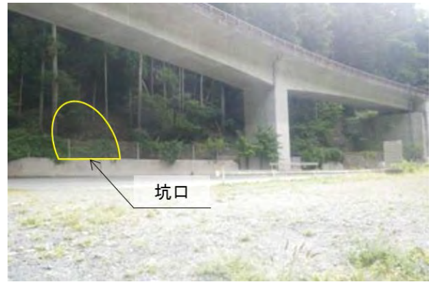
写真 2-2 早川東非常口の現況（非常口正面）
