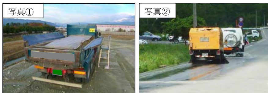
図 3-13 資材及び機械の運搬による影響を低減するための環境保全措置
