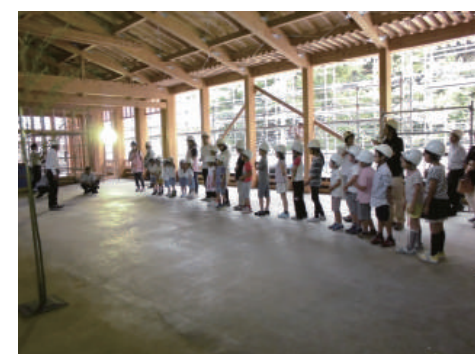
建設途中の現場見学会 木造の構造に触れる
