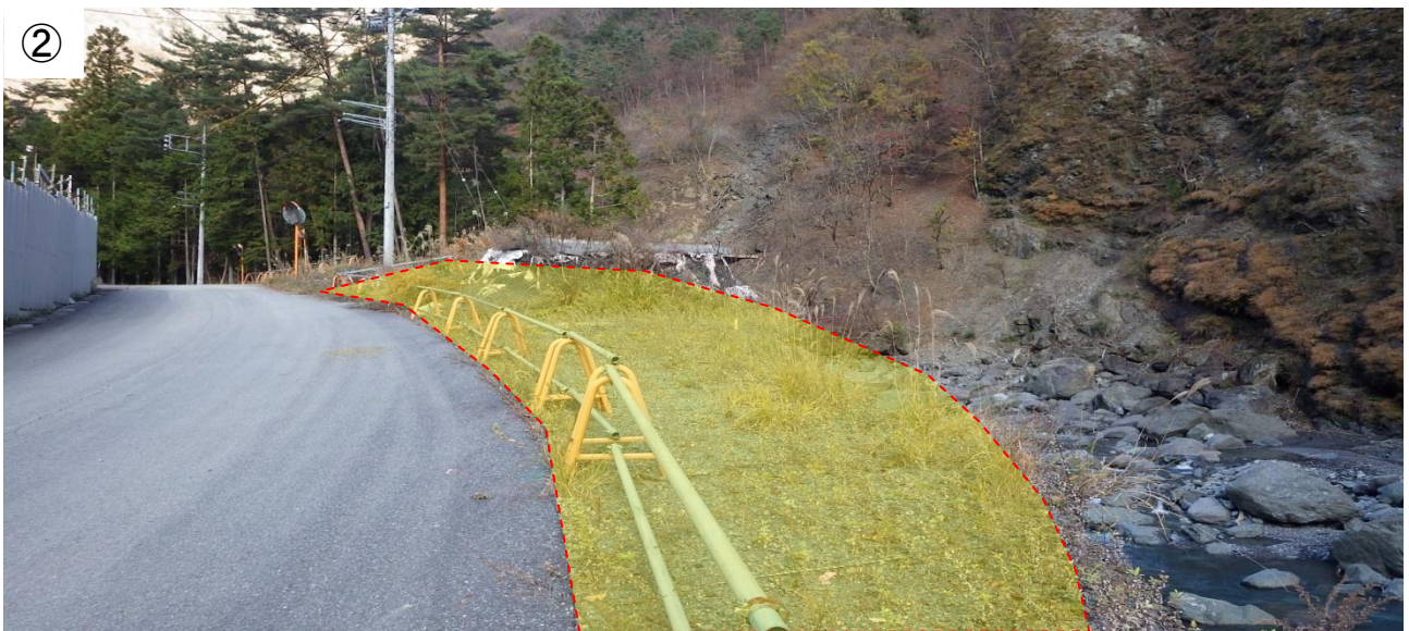
図 2 - 2 早川非常口の現況
