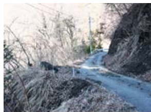
沿道の崩れているところを整備し、良好な景観形成と安全性の確保を図る
