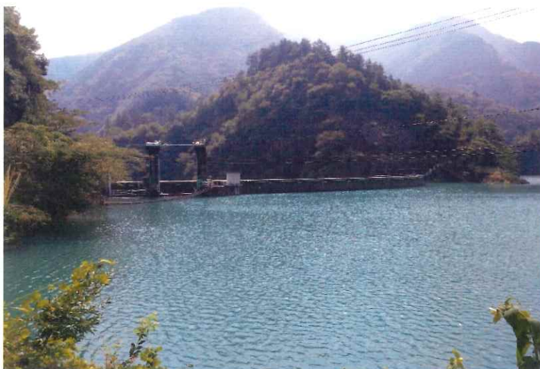
雨畑ダム付近
