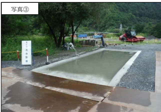
図 3-9 資材及び機械の運搬に用いる車両の影響を低減するための環境保全措置
